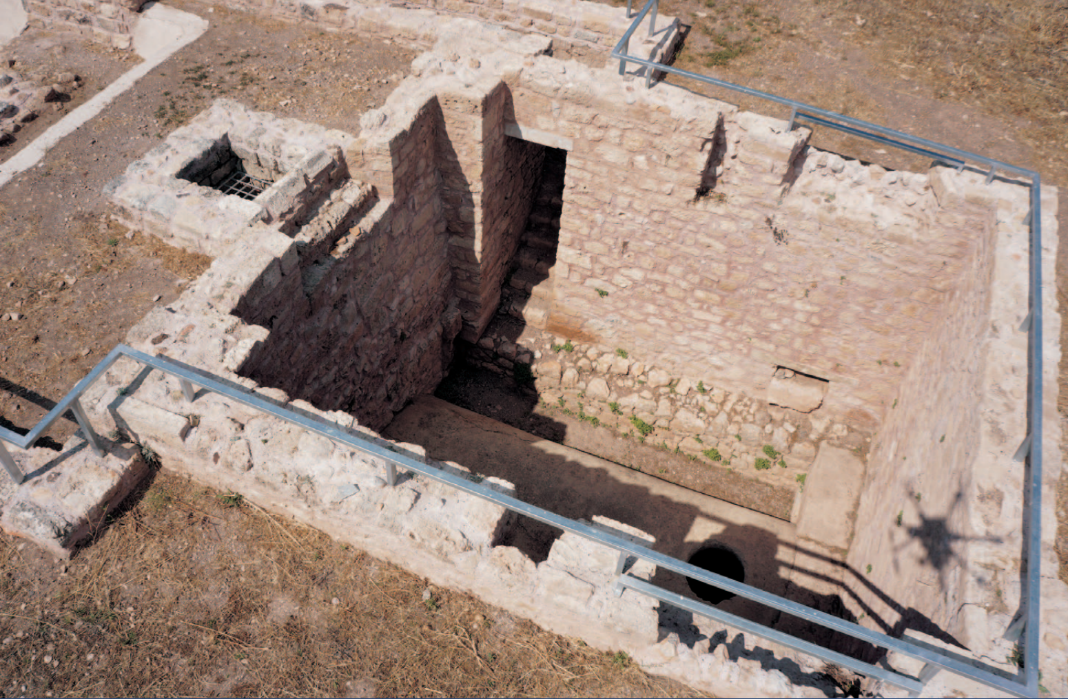
Αποκατάσταση χώρου πάνω από το θόλο της δεξαμενής Restoration of the space above the cistern's vault
