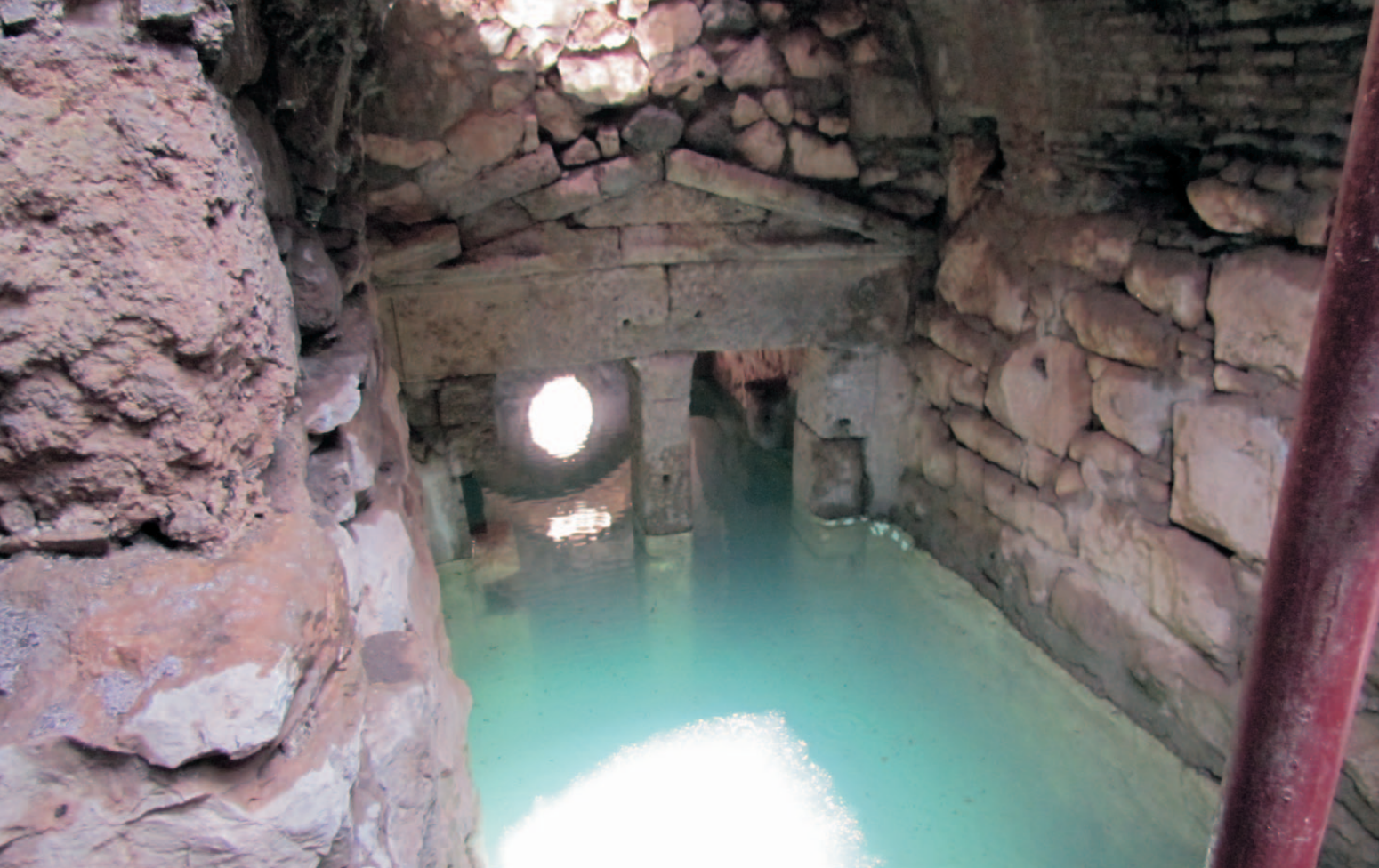
Κατάσταση δεξαμενής μετά τους καθαρισμούς Cistern after cleaning works
