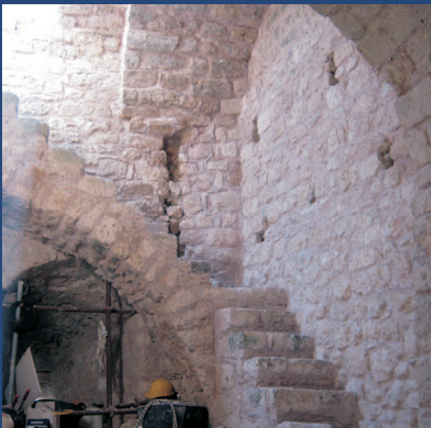
Αποκατάσταση εσωτερικής κτιστής κλίμακας Restoration of the interior built staircase
