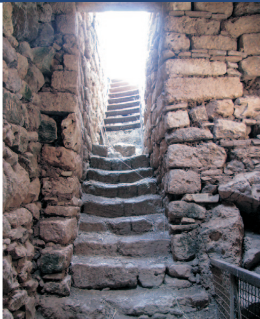
Αντικατάσταση φθαρμένης μεταλλικής κλίμακας με λιθόκτιστη Replacement of the metal ruined stairway with a stone built
