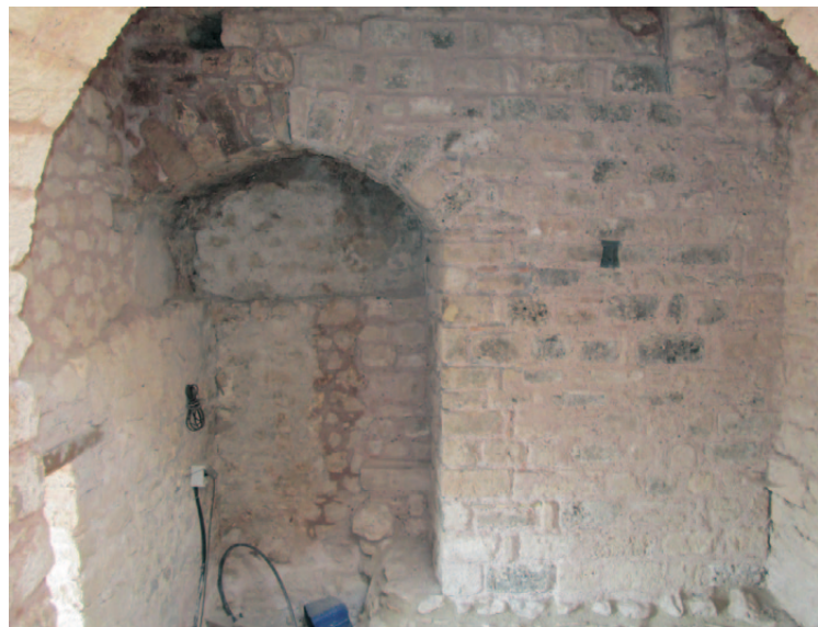
Διαμόρφωση τυφλού αψιδώματος στο δυτικό τμήμα Blind arch in the east part of the tower
