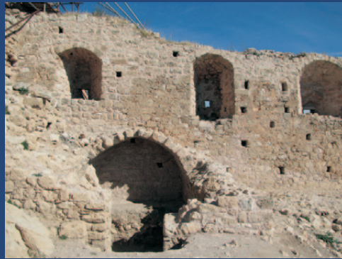
Συμπληρώσεις λιθοδομών ανατολικού τείχους Masonry filling of the enclosure's east wall
