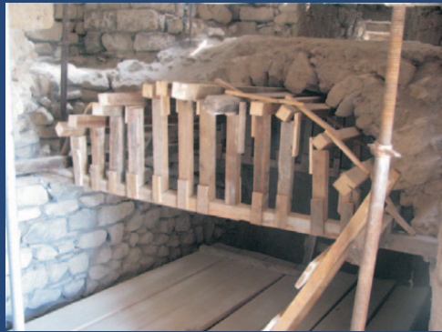
Εξυγίανση θολοδομίας κινιτέρνας Repair of the extradoses of cistern's dome
