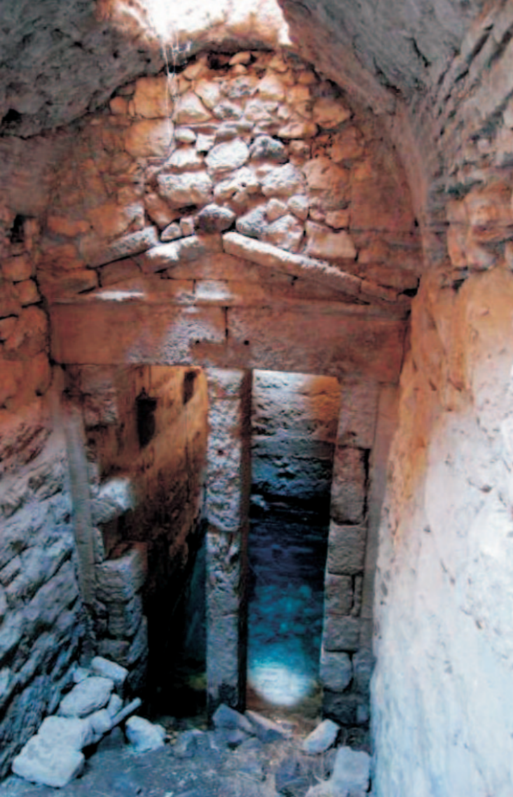
Διάφραγμα με αετωματική απόληξη στο εσωτερικό της δεξαμενής Double Opening in the Interior of the cistern
